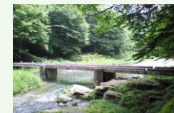
嵐山町_新緑の嵐山渓谷冠水橋
