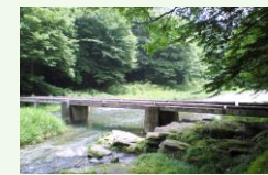
嵐山町_新緑の嵐山渓谷冠水橋
